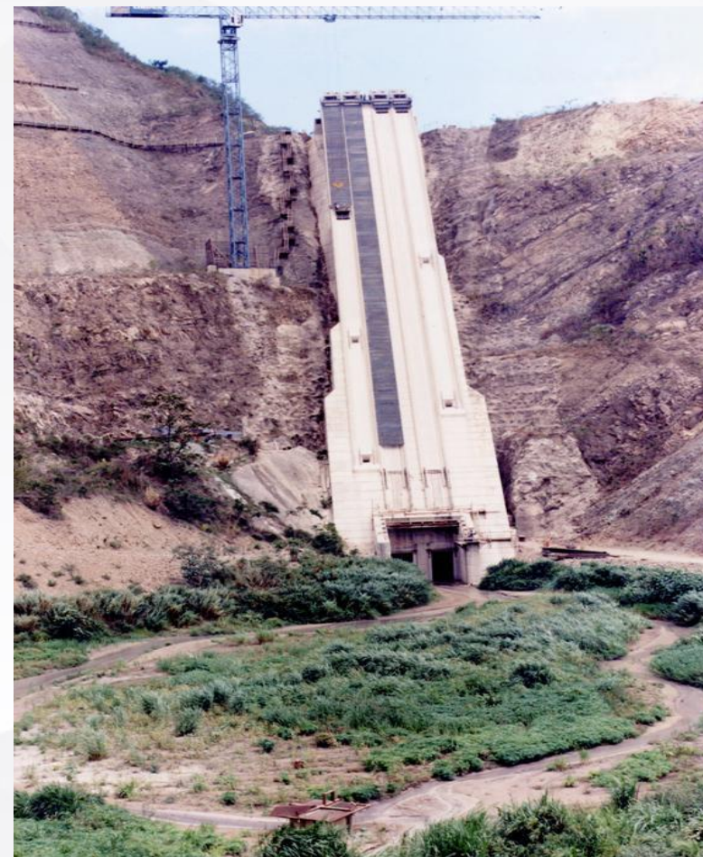
某水库斜坡式进口建筑物
