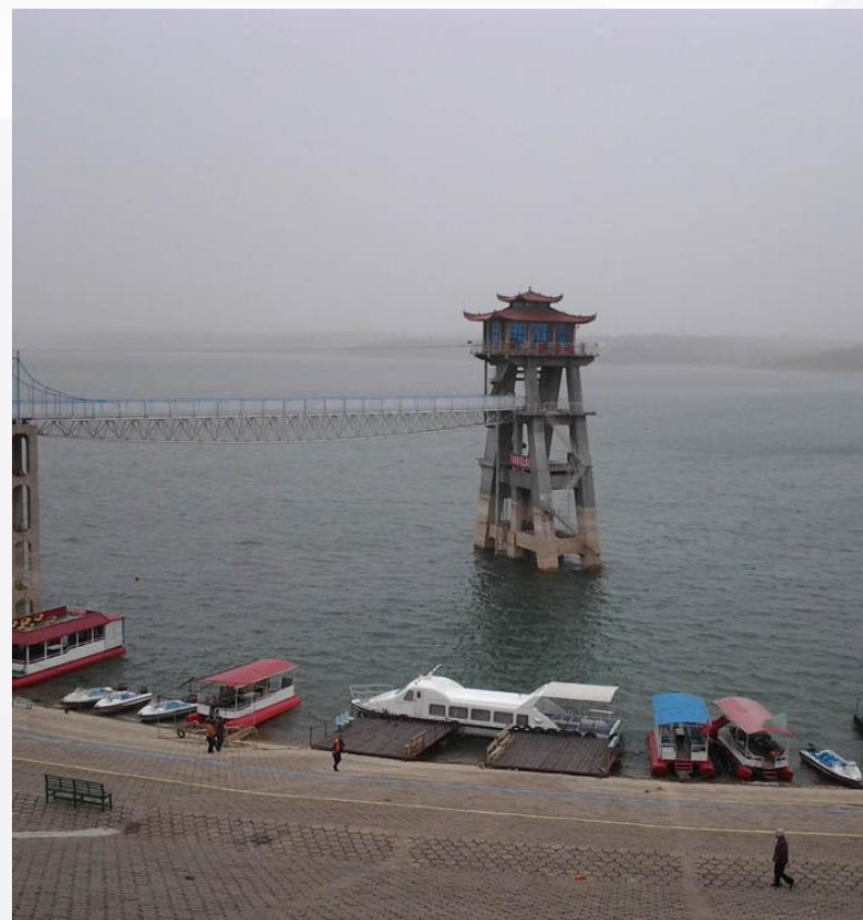
陆浑水库输水洞进口建筑物
