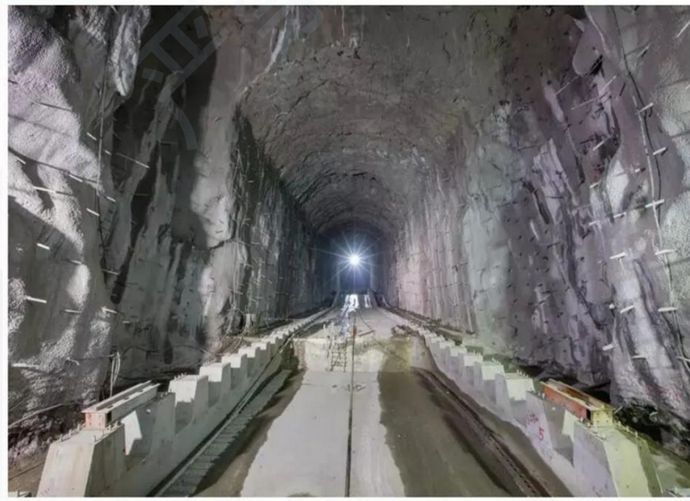
泄洪洞龙落尾段施工形象
