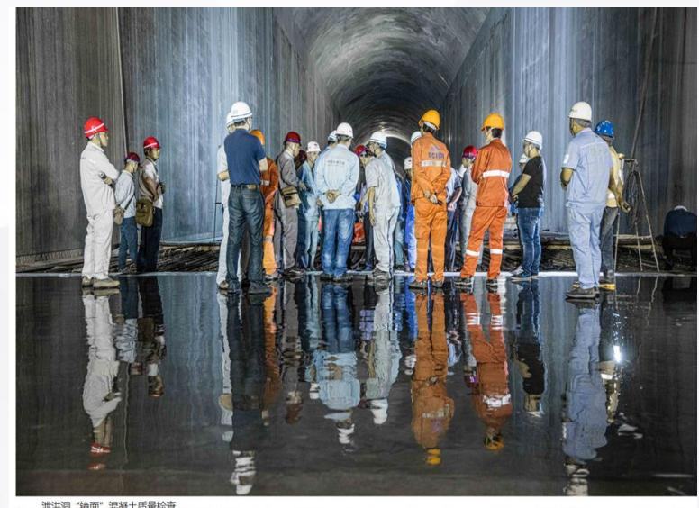
泄洪洞“镜面”混凝土质量检查
