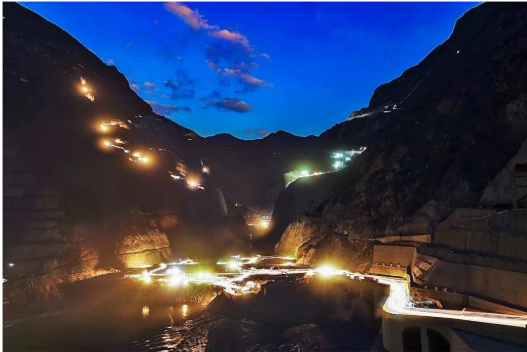
乌东德大坝上游围堰施工夜景
