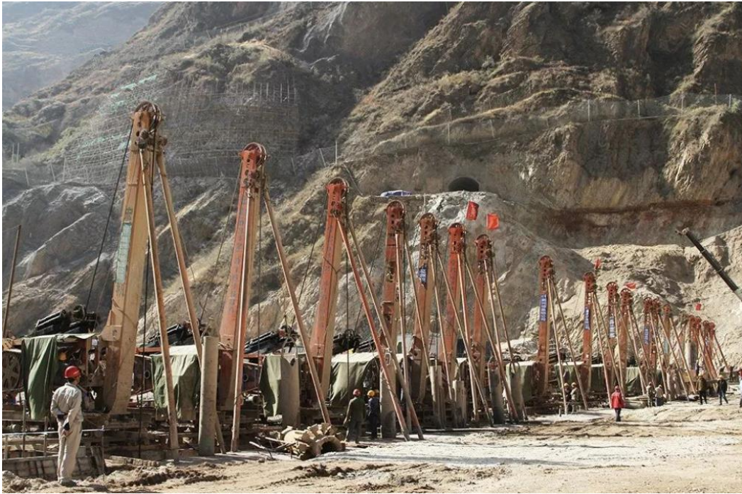
乌东德大坝上游围堰填筑及防渗墙施工
