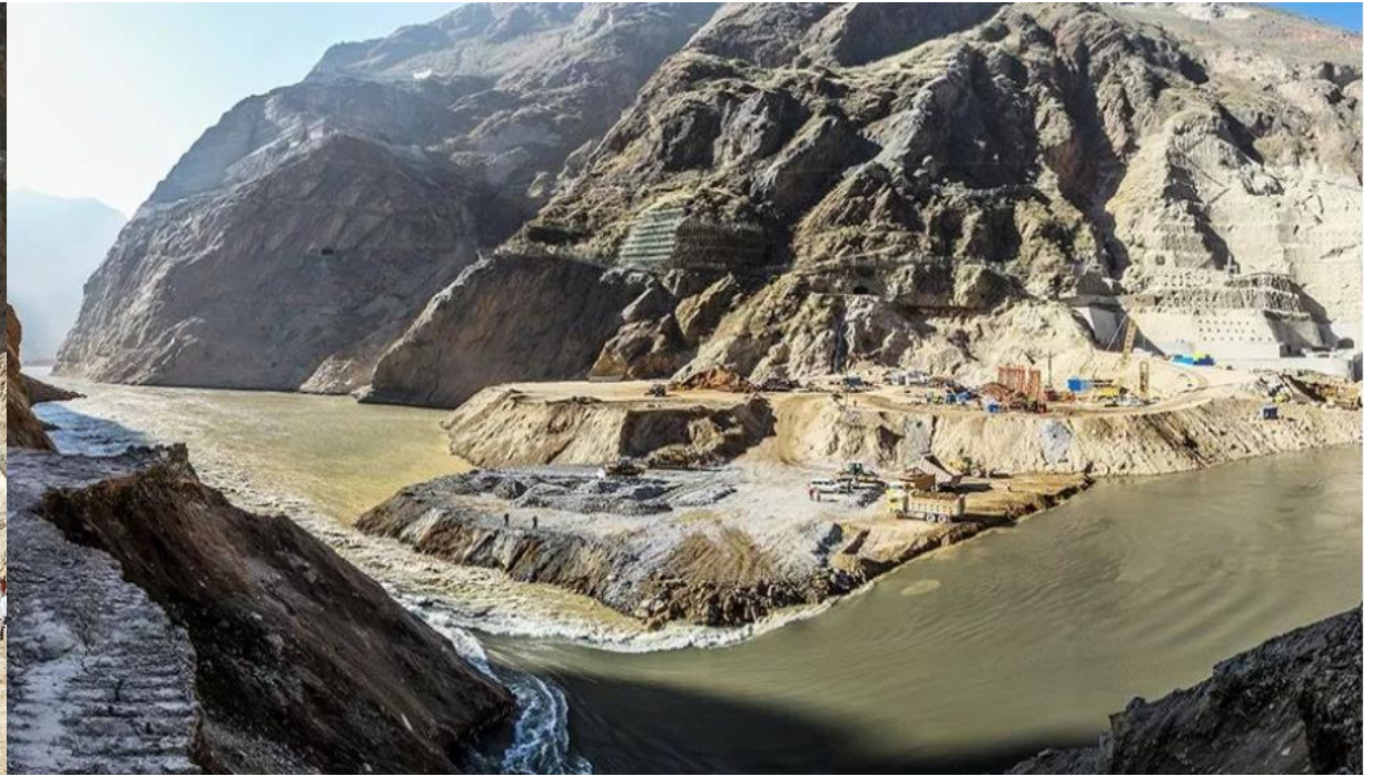
乌东德大坝上游围堰龙口段施工全景
