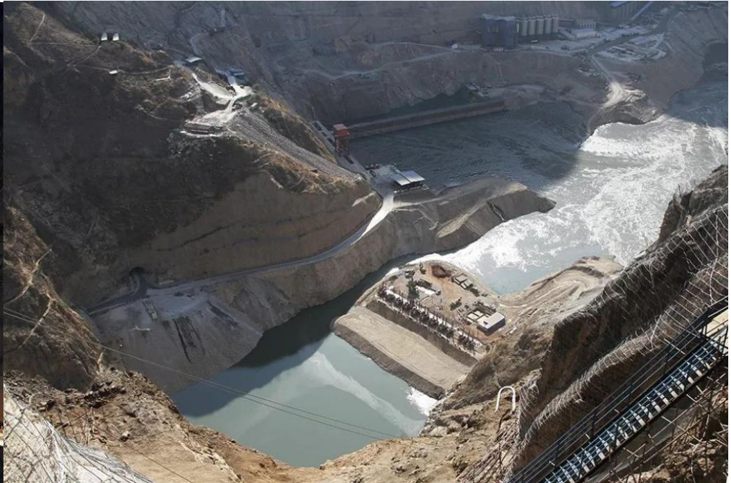
乌东德大坝下游围堰施工全景
