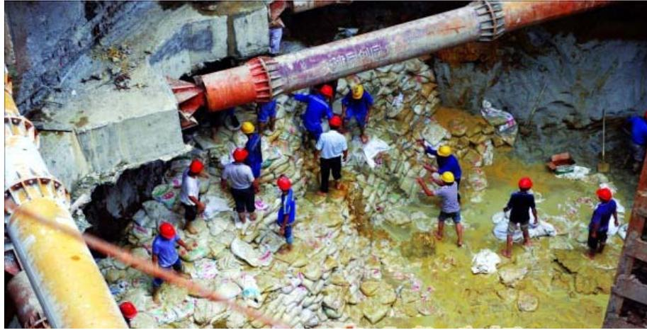
广佛地铁桂城站基坑出现流砂，地面下沉约 1.5m 图为砂包封堵
