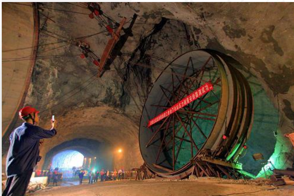
三峡工程引水压力钢管安装
